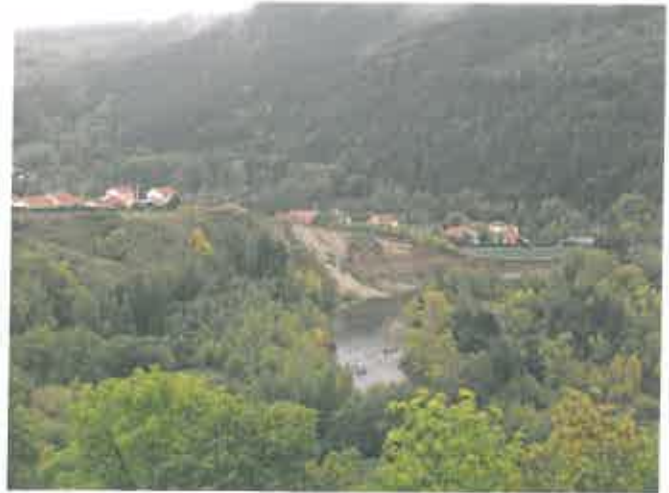
Érosion des berges de la Loire à Coubon (BRGM)
