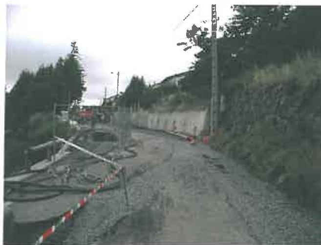
Glissement de terrain dans des colluvions d'argiles tertiaires au Monastier sur Gazeille (RD 500)
