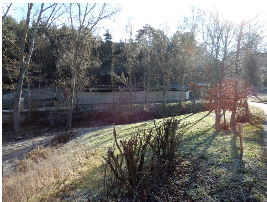
STATION D'EPURATION D'APILHAC
