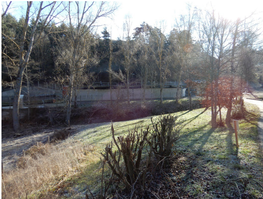
STATION D'EPURATION D'APILHAC
