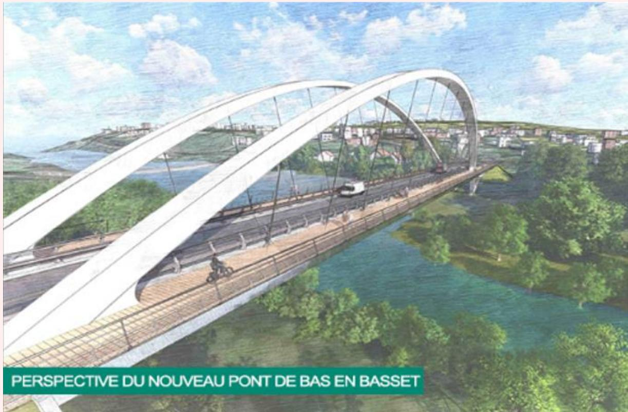
Le nouveau pont aura une longueur de 158,45 mètres, la pente de l'ouvrage est ascendante à 2,1% de la rive gauche à la rive droite. Il comportera une voie mode doux de 2,50 mètres par sens, une chaussée de 7,50 mètres composé de 2 voies de 3,50 mètres bordées de caniveau de 25 centimètres de largeur et terre-plein central de 0,3 mètre.
